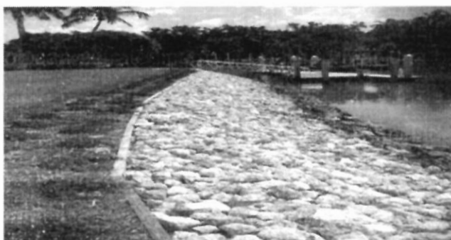
Fig. 33 - Protección de talud con enrocado
