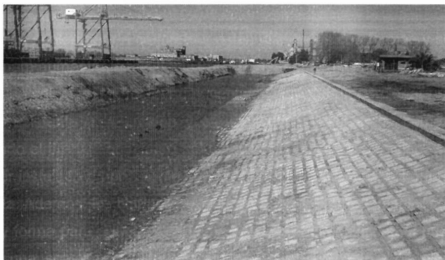
Fig. 35 - Protección de talud con bloques adheridos a geotextil
