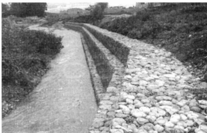
Fig. 34 - Protección de talud con colchonetas y gaviones
